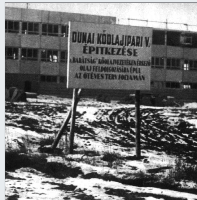
A központi irodaház építése
