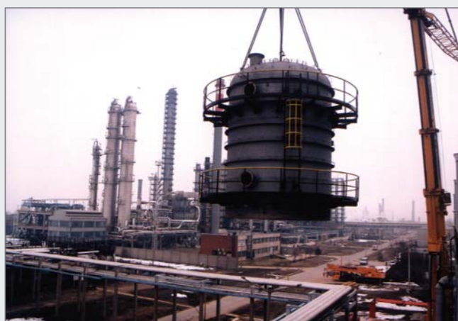
Az AV-2 üzem toronyfejének beemelése
