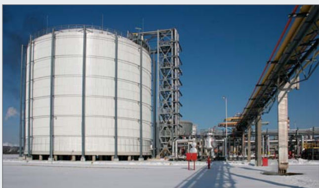
Etiléntartály a TVK-ban, előtérben csővezetékkel
