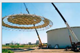
Tartálytető beemelése
